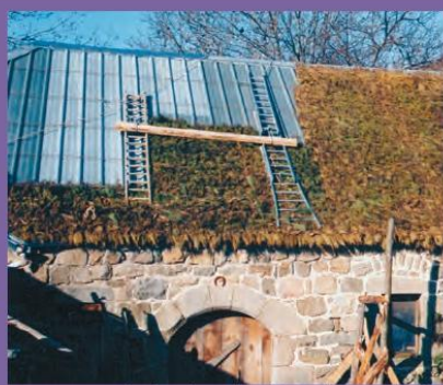
Borée, rénovation d'une toiture en genêts
