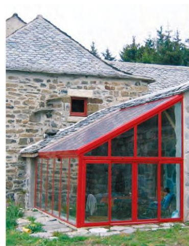
Loggia vitrée en extension
