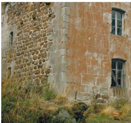
Saint-Clément, diversité des assemblages de pierre
