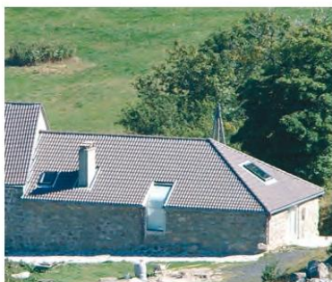
Saint-Martial, ouvertures créées en combles
