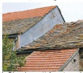
Le Béage, lauzes et tuiles en terre cuite
