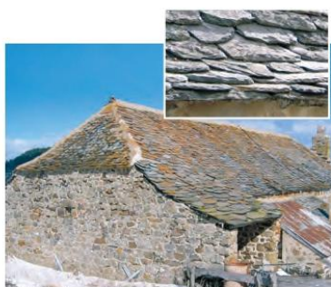
Borée, toiture de lauzes
