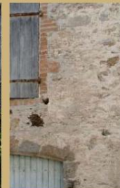
Enduit de jointoiment.
