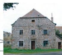
Le Béage, toiture à pignon rehaussé
