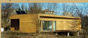
Maison à ossature et bardage bois.
