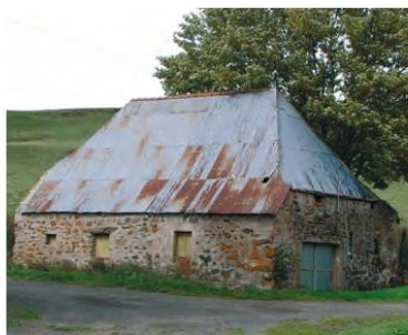
Le Béage, toiture en tôle
