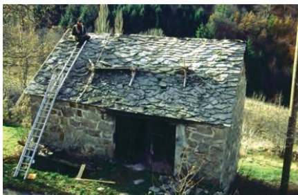
Réparation d'une toiture de lauzes
