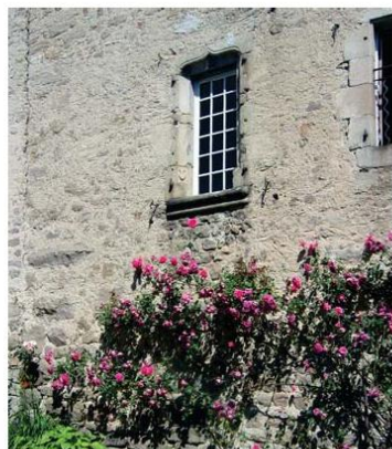
Mur de pierre avec un enduit de jointoiment.
