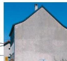
Saint-Martial, toiture à deux pentes avec coyau
