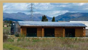
Bâtiment artisanal en bois avec panneaux photovoltaïques.
