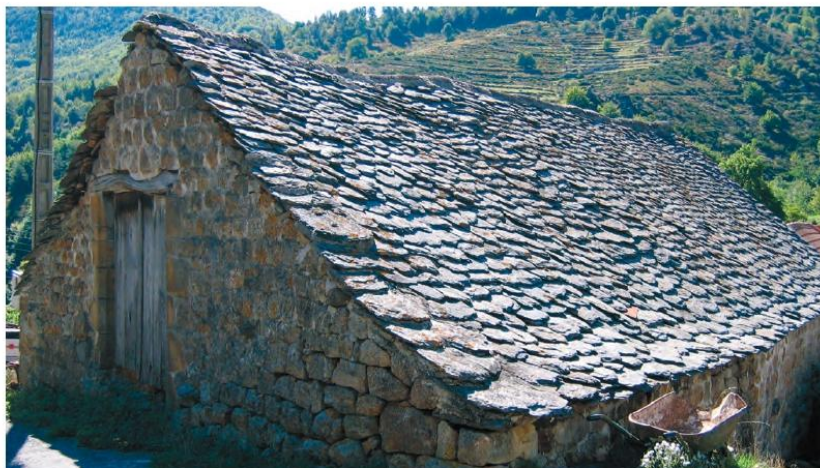
Le Chambon, toiture ancienne de lauzes
