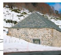
Toiture à quatre pentes
