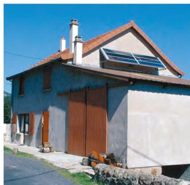
Panneaux solaires, Saint-Martial
