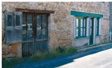
Saint-Martial, anciennes portes de remises
