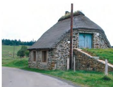
Borée, toiture de chaume
