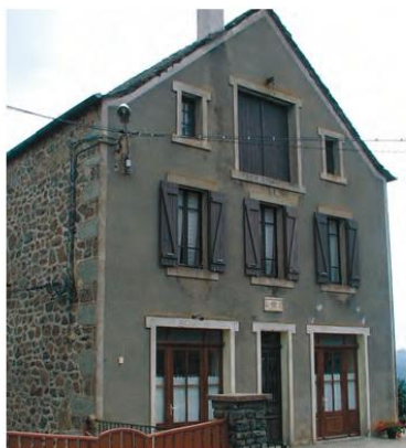
Borée, façade pignon couverte d'un enduit laissant apparaître les encadrements de fenêtres en saillie. Ces décorations donnent une certaine noblesse à la façade principale. La façade latérale, moins visible depuis la rue reste en pierre apparente avec joints bien couvrants à la chaux.
