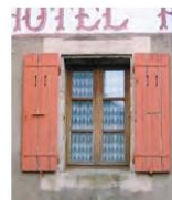
Fenêtre plus haute que large, volets à lames. Teintes chaleureuses et discrètes des menuiseries.
