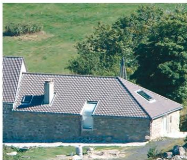
Saint-Martial, ouvertures créées en combles
