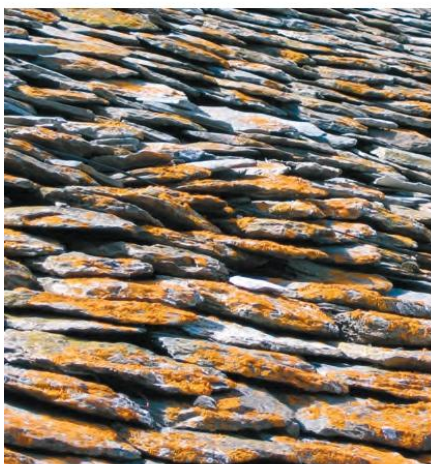
Détail d'une toiture de lauzes
