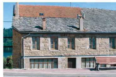
Saint-Martial, agrandissement d'ouvertures avec un linteau métallique. Paradoxalement, ce type de linteau est cohérent dans l'organisation de la façade.
