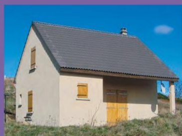
Teinte neutre de l'enduit captant la lumière naturelle et créant un ensemble harmonieux avec la couleur sombre de la toiture
