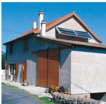
Panneaux solaires, Saint-Martial
