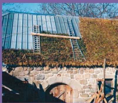
Borée, rénovation d'une toiture en genêts
