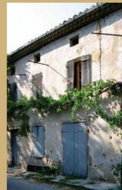
Ancien enduit à la chaux.
