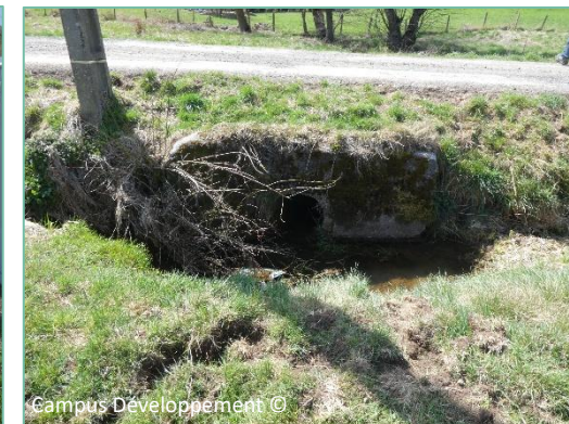
Vue d'un fossé servant d'écoulement pluvial
