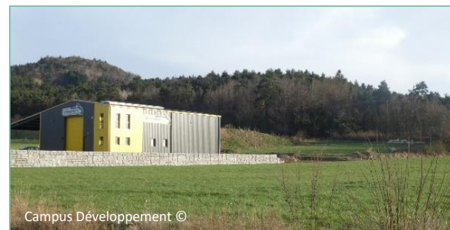
Vue de la zone au Nord-Ouest du site (entreprise TP) depuis la RD 39
