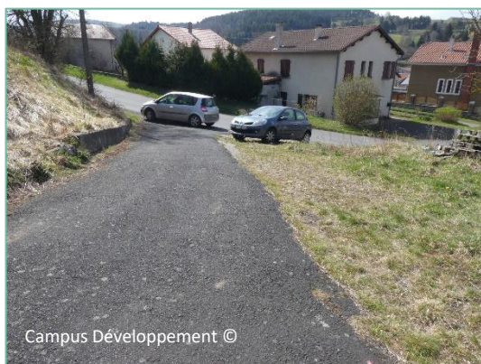
Accès au site par la route du Fraisse au Sud
