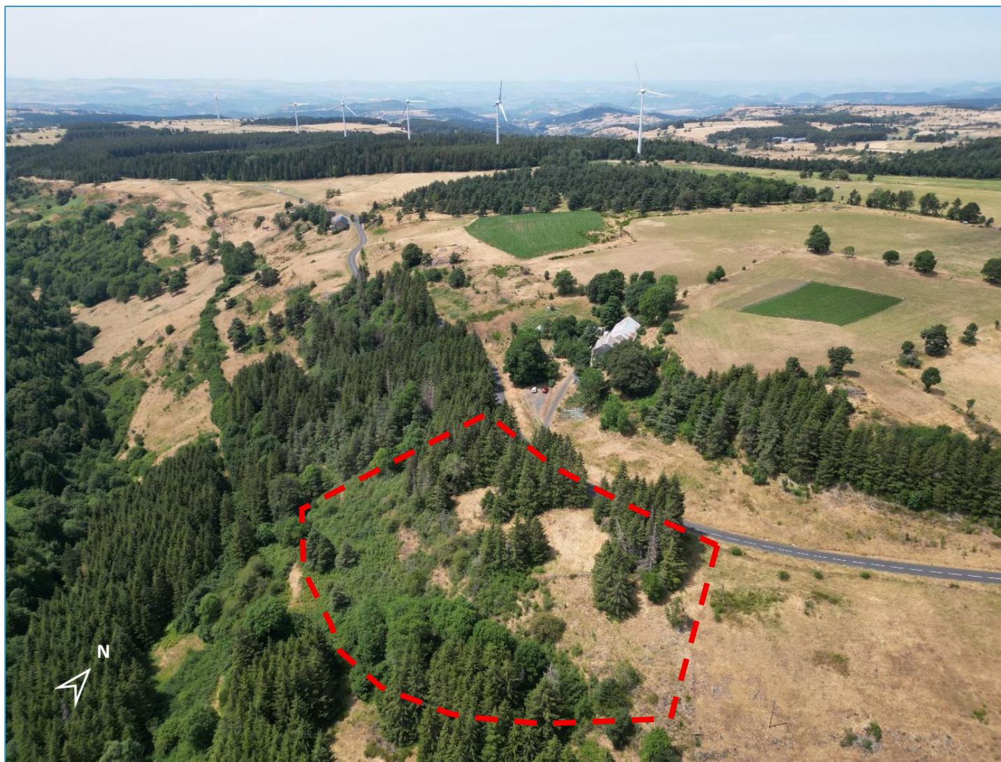
Vue aérienne du site au regard du parc éolien © Campus Développement
