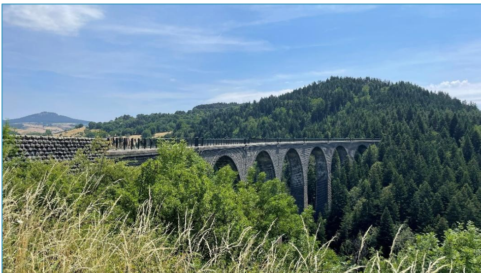
Viaduc de la Récoumène © Campus Développement
