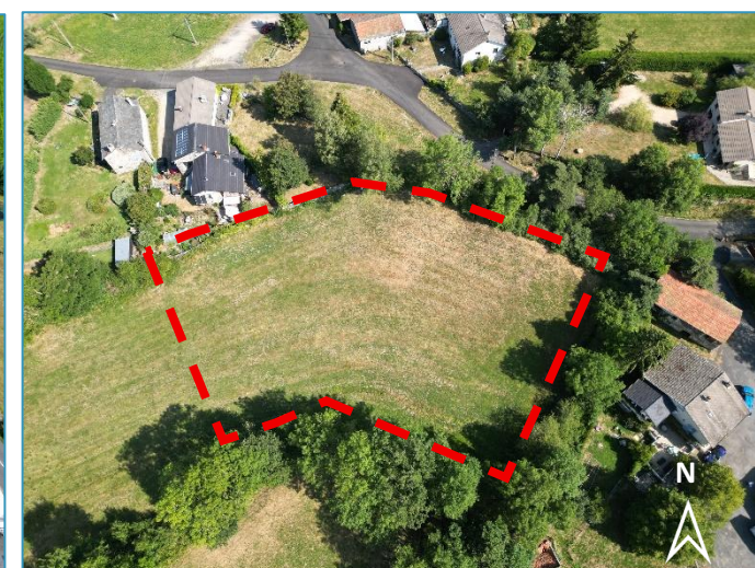
Vue aérienne du secteur d'OAP « Secteur RN 88 – Cellier » à St-Pierre-Eynac – © Campus Développement
